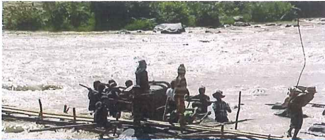
Transport von Betonmischer und Baumaterial über einen Behelfssteg.
