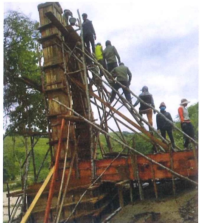
Facharbeiter gießen mit Hilfe von Frauen und Männern aus Daktaork Noi die Träger der Hängebrücke.
