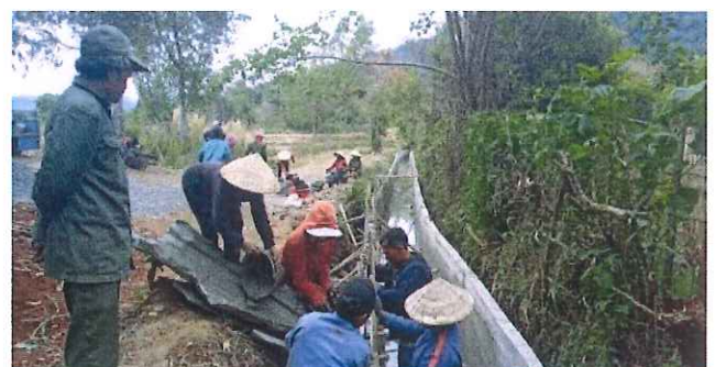
Bauarbeiten am Bewässerungskanal Houyxay
